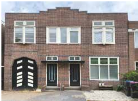
Garage met bovenwoning en met de woning ernaast, Lijsterstraat 28 en 28A. Perceel is nu gemeentelijk monument.
